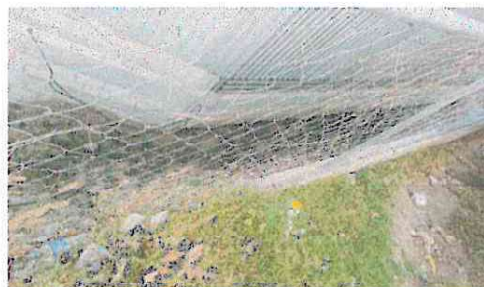
Foto 2: Agujeros en malla perimetral pueden causar accidentes
